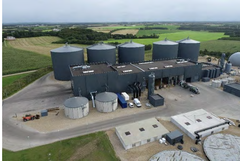
NE Videbæk biogas
