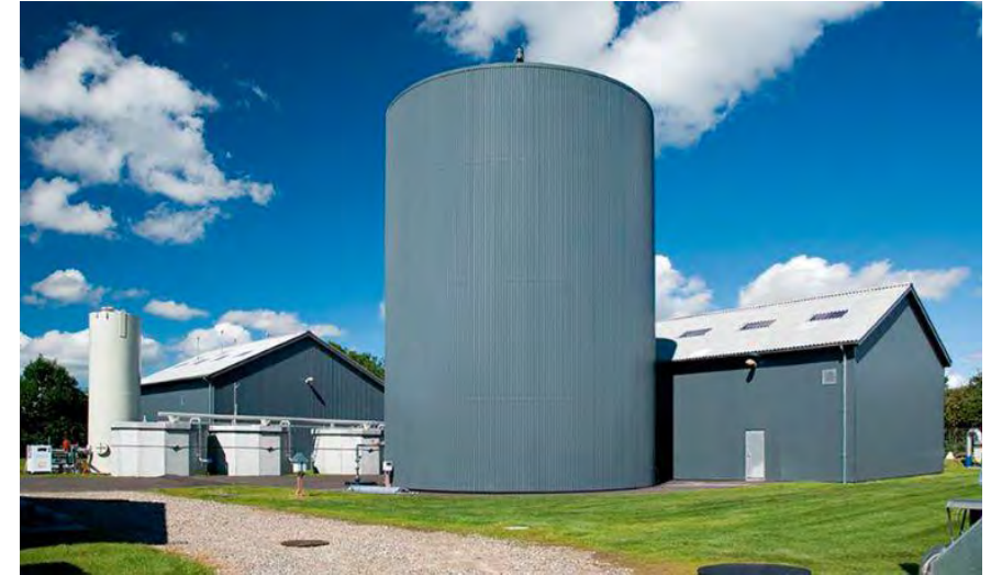
AU Foulum biogas
